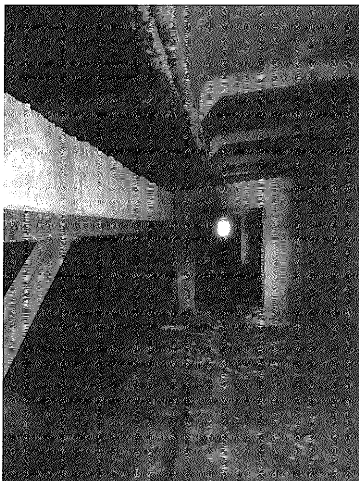
Фрагмент покрытия чердачного
